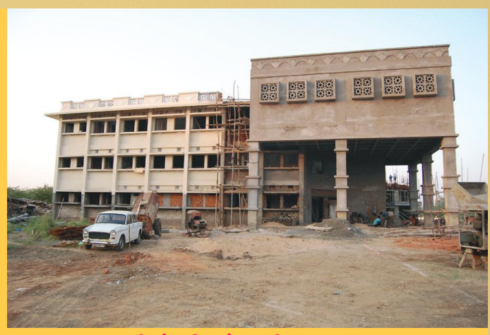
निर्माणाधीनं भोपालपरिसर भवनम्
